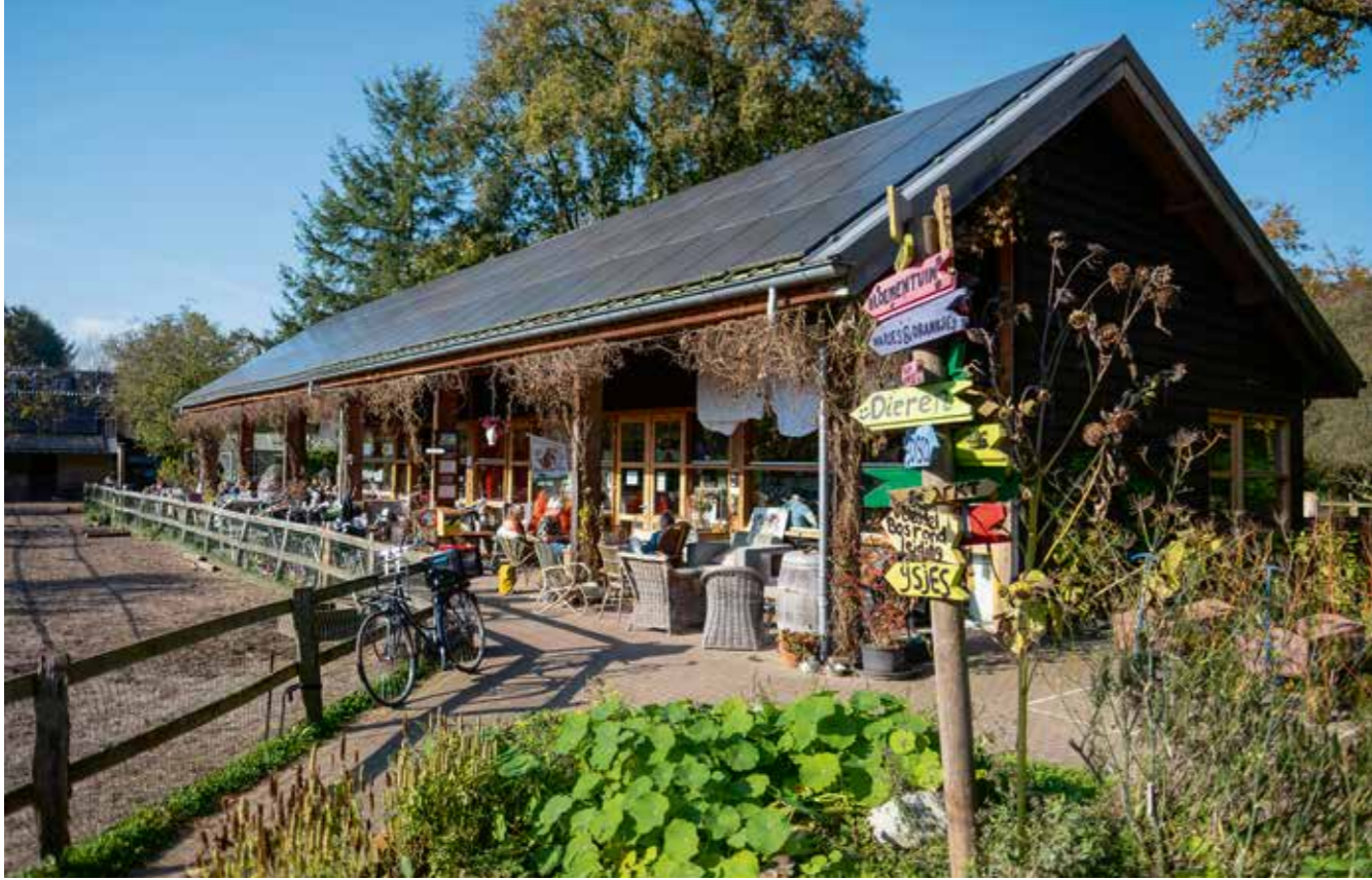
Het houten receptiegebouw De Hop met zorgboerderij ligt vol zonnepanelen. De vrolijke paal met richtingaanwijzers is door deelnemers van de zorgboerderij gemaakt in het kader van het 75-jarig bestaan.
